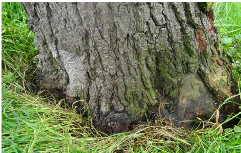
Afbeelding 2: Voorbeeld stamvoetschade (boom 37430)
