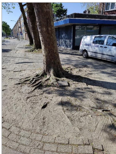
Afbeelding 1: Plataan 3, oppervlakkige beworteling
