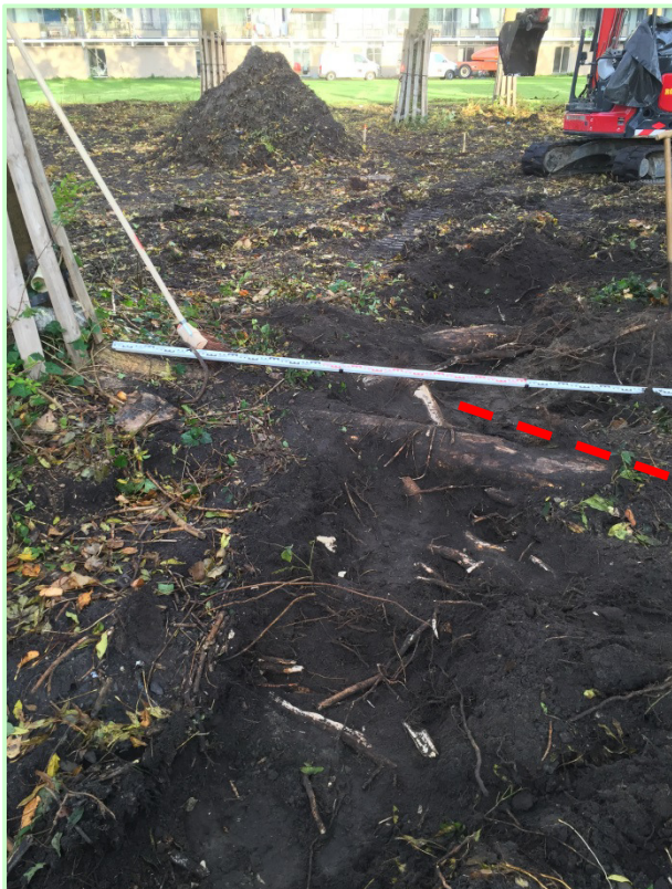
Overzicht van de proefsleuf, gegraven op de locatie waar het riool geplaatst moet worden.
